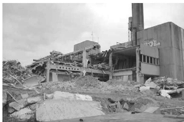
Asbestbelastung: Abbruch des Bildungszentrums Wilhelmstraße (Bertolt-Brecht-Oberschule) Spandau
